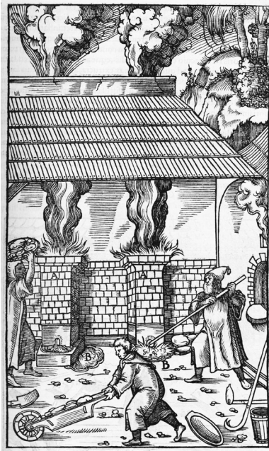
Abb. 4: Darstellung einer frühneuzeitlichen Schmelzhütte mit verschiedenen Öfen, in denen das wertvolle Metall erschmolzen und somit die Stoffe der Natur »vollendet« wurden – in Georgius Agricolae Verständnis. Entnommen aus Georgius Agricola: De re metallica libri XII , Basel 1556, S. 287.
